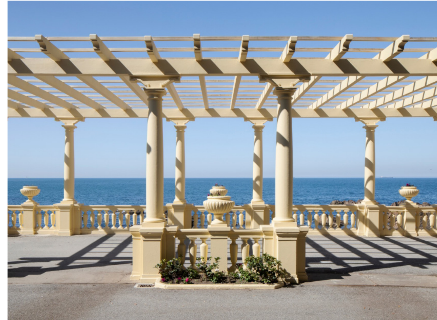
Pérgola da Foz, Porto Banema
